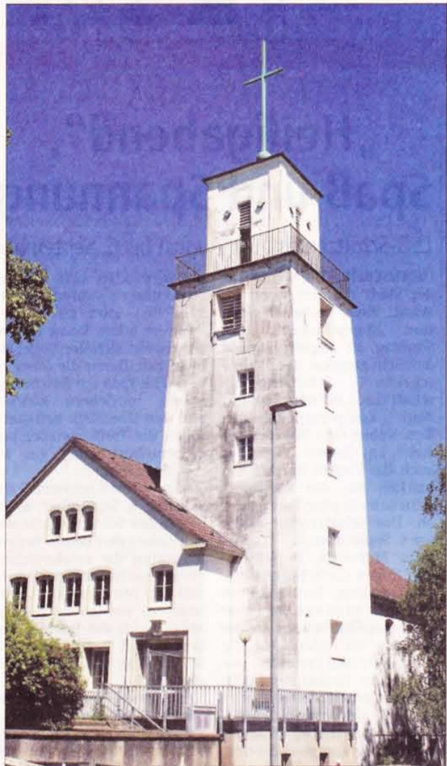
Noch strahlt das Weiß des Turms der alten Kreuzkirche. Doch Feuchtigkeitsschäden haben dem Bauwerk bereits stark zugesetzt.
