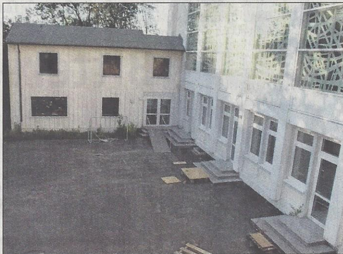
Blick auf den Eingangsbereich der Jugendetage der Kreuzkirche. Das abgebildete Außengelände soll den Kindern und Jugendlichen in Zukunft ebenfalls zur Verfügung stehen.
